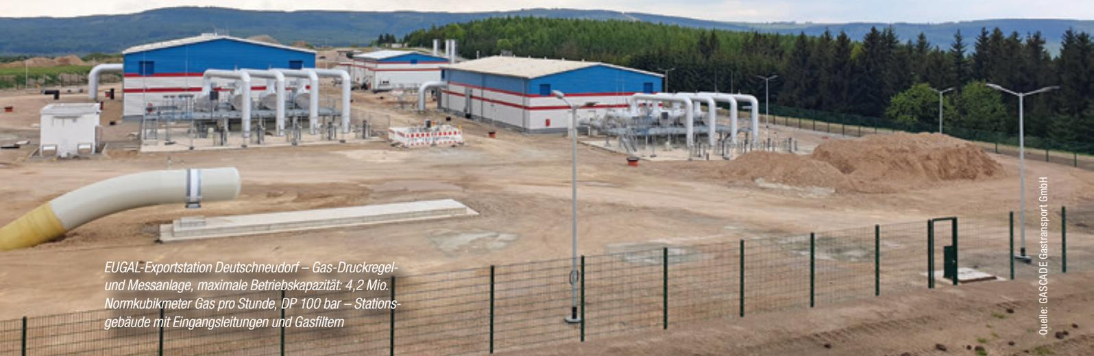
EUGAL-Exportstation Deutschneudorf – Gas-Druckregel- und Messanlage, maximale Betriebskapazität: 4,2 Mio. Normkubikmeter Gas pro Stunde, DP 100 bar – Stationsgebäude mit Eingangsleitungen und Gasfiltern
