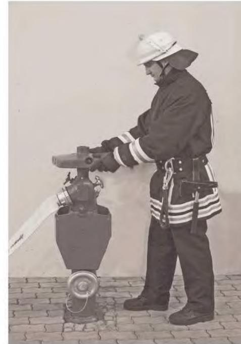
Mit dem Überflurhydrantenschlüssel wird durch Linksdrehen des Dreikants die Sperre des Fallmantels gelöst. Dann werden die oberen Ventilabgänge frei.
